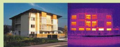
Vila blok s 6 stanovanji Termografski posnetek
